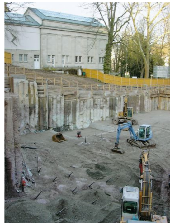
Baustelle Museum Frieder Burda, 5. März 2003 / Le chantier de construction, 5 mars 2003
